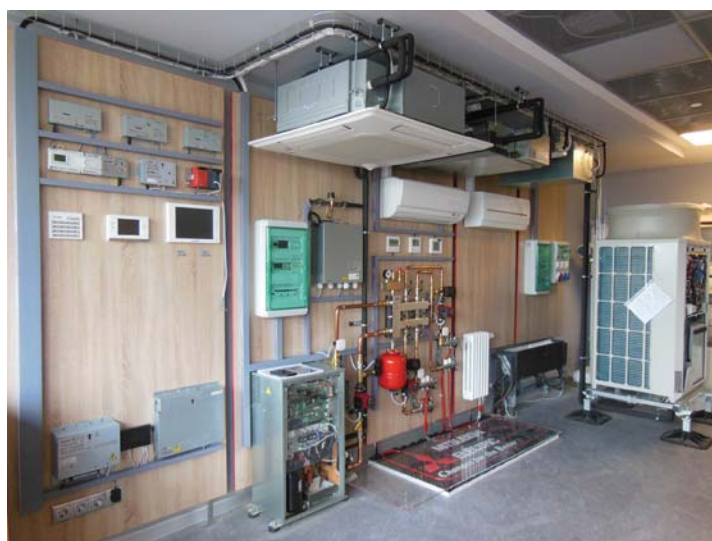
ДВУХТРУБНАЯ VRF-СИСТЕМА R2 С УТИЛИЗАЦИЕЙ ТЕПЛОТЫ
